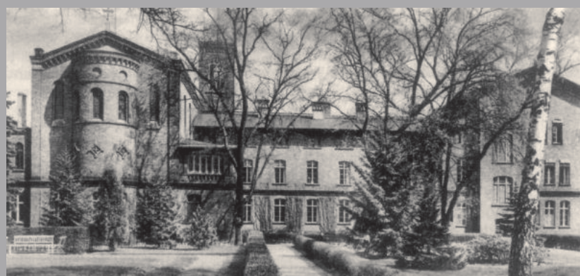
Widok na kaplicę od strony ogrodu - fot. ze zbiorów portalu Sedina.pl
